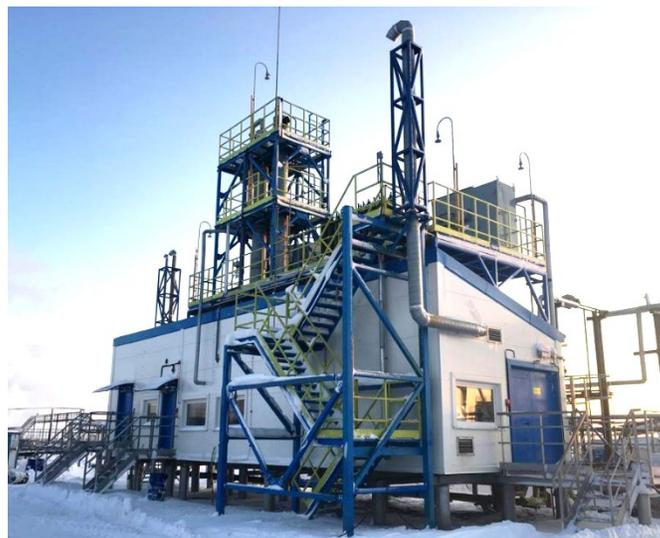
Такой комплекс подготовки газа функционирует на Северо-Мукеркамьльском месторождении, обустройство которого ведет нефтегазовая компания «Горный». Контракт был реализован «под ключ» в короткие сроки. Полный спектр работ, начиная от проекта и изготовления оборудования до монтажа на месторождении и ввода в эксплуатацию, был выполнен специалистами ПГ «Безопасные Технологии».
